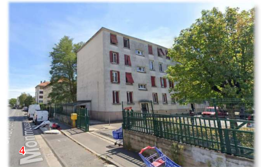
Vue sur une barre de logements collectifs située en bordure de l'avenue Gaston Monmousseau
