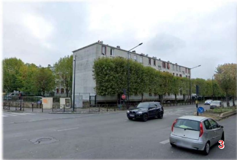
Vue sur une barre de logements collectifs située à l'angle du boulevard Maxime Gorki (N301) et de l'avenue Gaston Monmousseau
