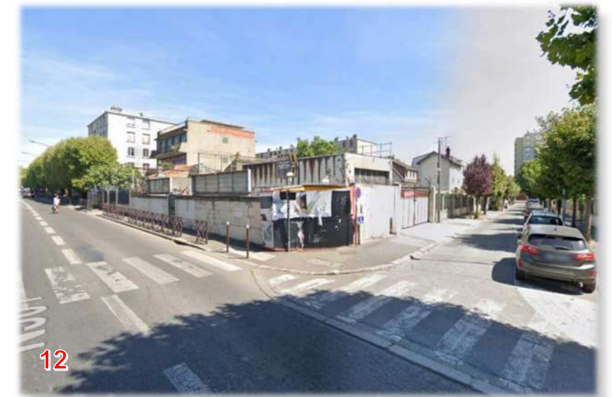
Vue sur un bâtiment d'activités (récupération de métaux) à l'angle de la rue Jules Trémel et du boulevard Maxime Gorki (N301)
