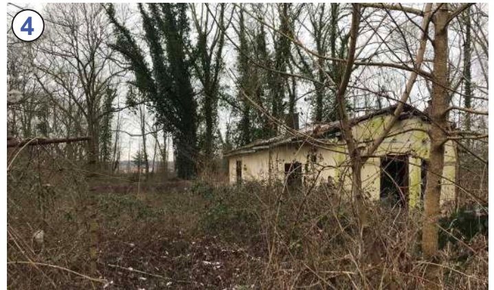
Vue de la maison abandonnée à démolir
