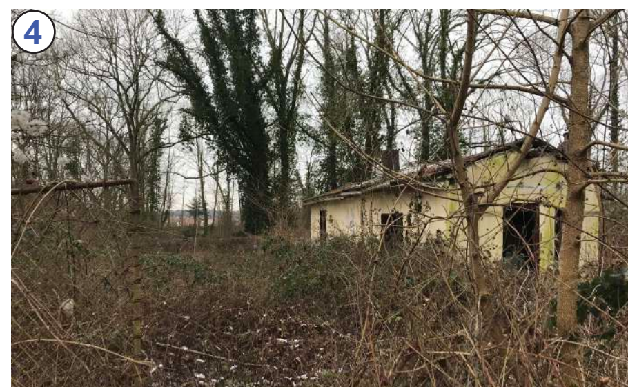
4- Vue d'une construction depuis le chemin contigu au cimetière
