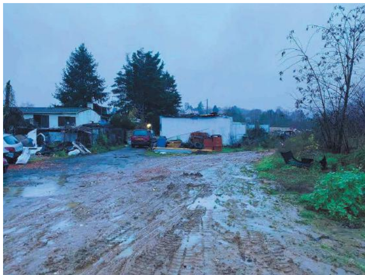
Photo 2 : Vue d'ensemble au nord de la zone d'étude
