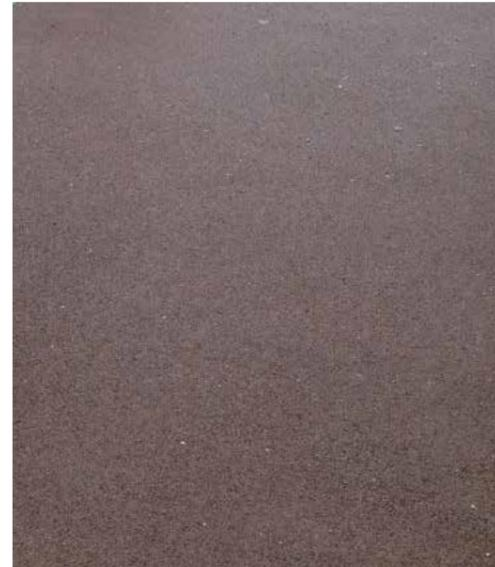
▲ Béton bitumineux noir hydrodécapé // TCSP
