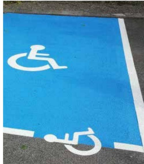
▲ Béton bitumineux + résine bleue et marquage résine blanche
