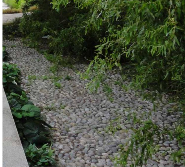
Selon sa mise en oeuvre les espaces de noues minéralisées permettent un stockage des eaux avant de les évacuer par infiltration dans le sol, et au besoin par un réseau canalisé, à un débit régulé, font référence à un ruisseau et facilitent l'entretien de la partie basse.
