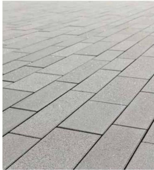
▲ Pavés béton à joints drainants (accessible aux PMR)
