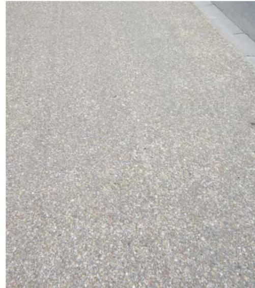
▲ Béton bitumineux noir hydrodécapé // Chaussée partagée // TCSP
