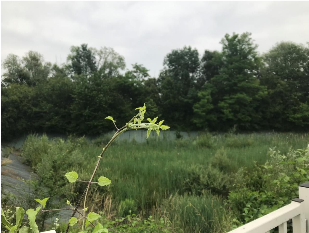
Photographie 19 : Bassin de rétention des eaux pluviales
