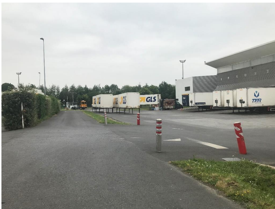
Photographie 12 : Vue du chemin communal et zone de livraison
