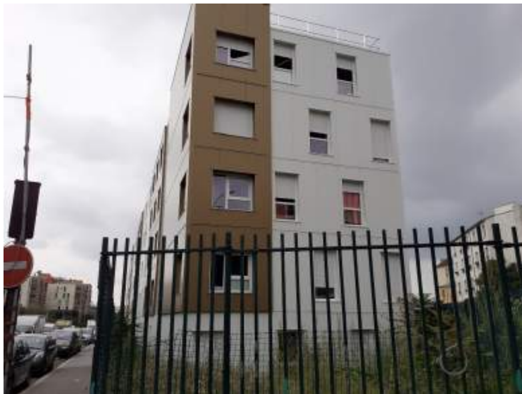
Photographie 5 : Vue de l'intérieur du site depuis l'intersection rue C. Schmidt / rue E. Vaillant
