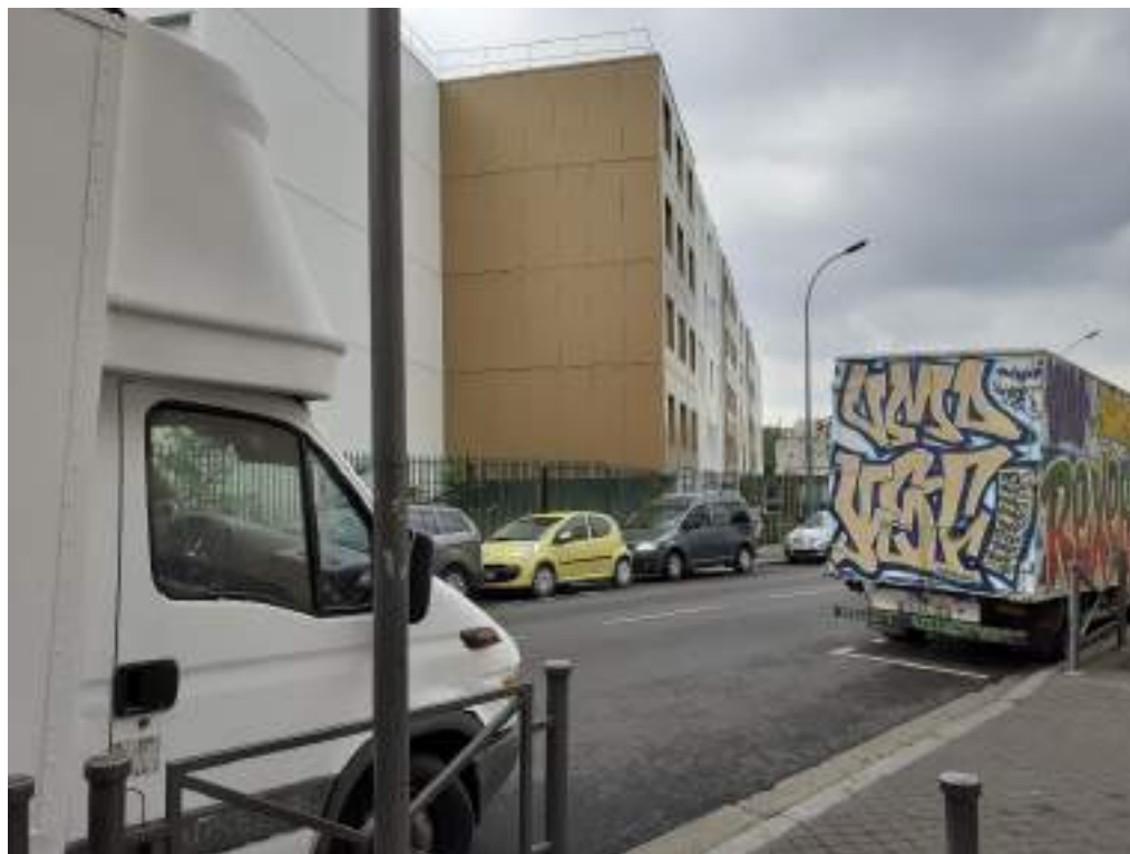
Photographie 3 : Vue du site depuis la rue Charles Schmidt
