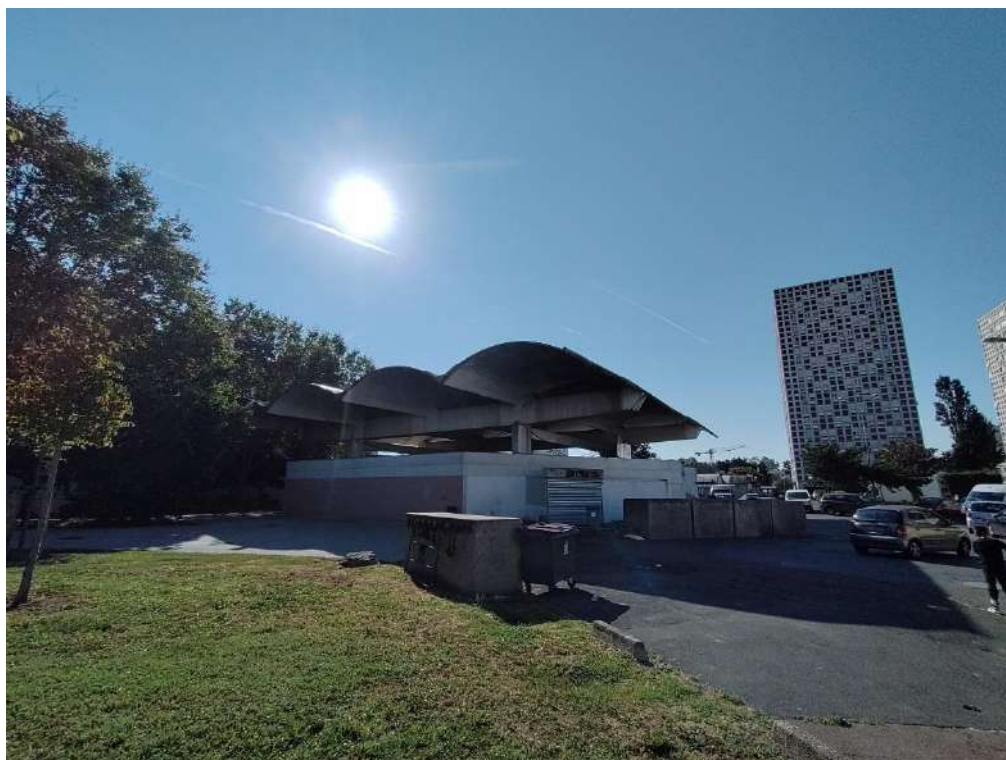
Photographie 10 : Façade nord du site 1/2
