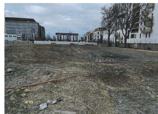
2. Localisation de l'ancien bâtiment 216 démol
