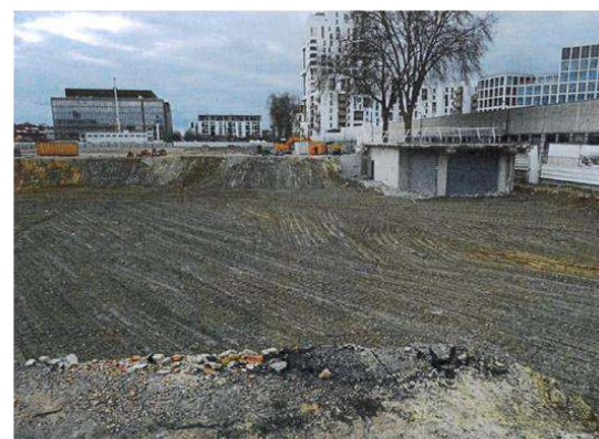
3. Localisation de l'ancien bâtiment 226 démol, le local du transformateur sera démol d'ici 2022
