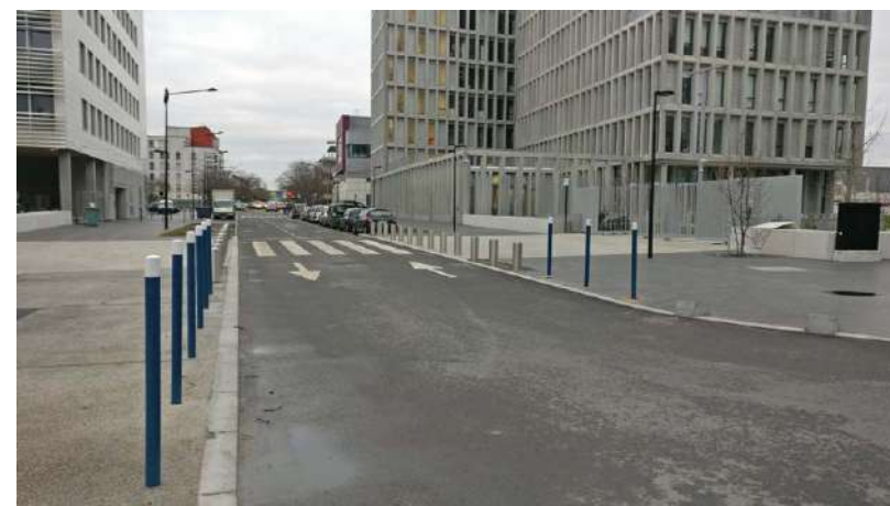
Figure 2-4 : Prolongement de l'avenue de la Métallurgie (Source : Transitec – Visite de terrain du 20.02.20)
