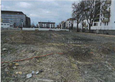
2. Localisation de l'ancien bâtiment 216 démol
