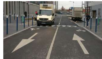
Figure 2-14 : Zone de circulation apaisée - Avenue de la Métallurgie
