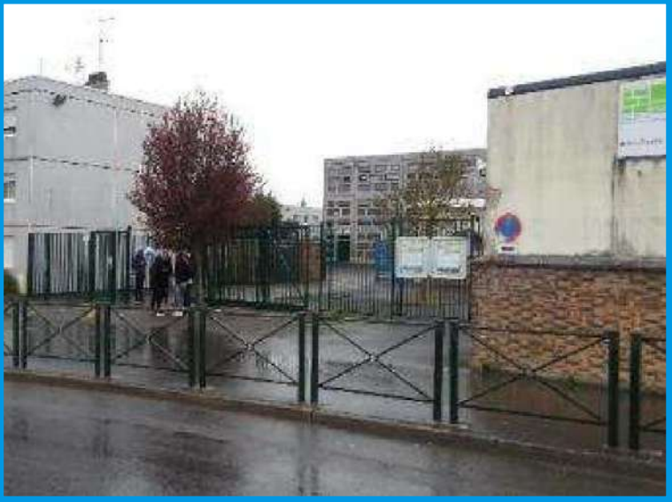
1. Entrée de l'établissement
