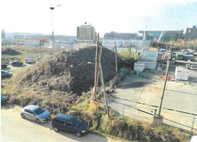
5 – Butte de terre au centre-est des emprises vue d'est en ouest.
