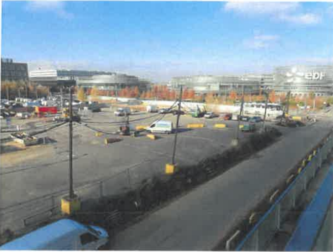
1 – Partie nord des emprises (lots C1.4 et C1.6) vue depuis la résidence étudiante Monge (rue Reine Bathilde) vers le nord-ouest.
