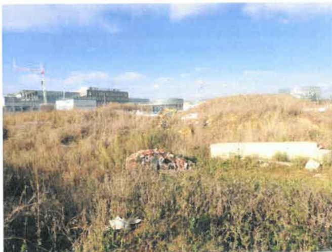
11 – Partie nord du lot C1.7 vue vers le nord-ouest : espace chaotique (remblais de terre) végétalisé avec présence de gravats...
