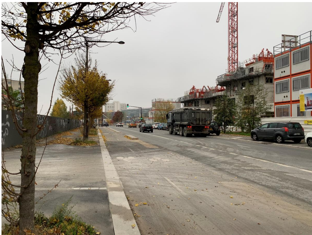
Photographie 15 : Vue vers le Nord depuis la rue des Péniches
