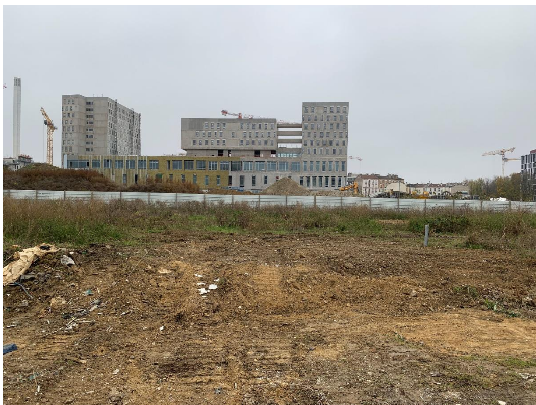
Photographie 2 : Vue depuis l'entrée du site vers le Sud-Est – rue Moise
