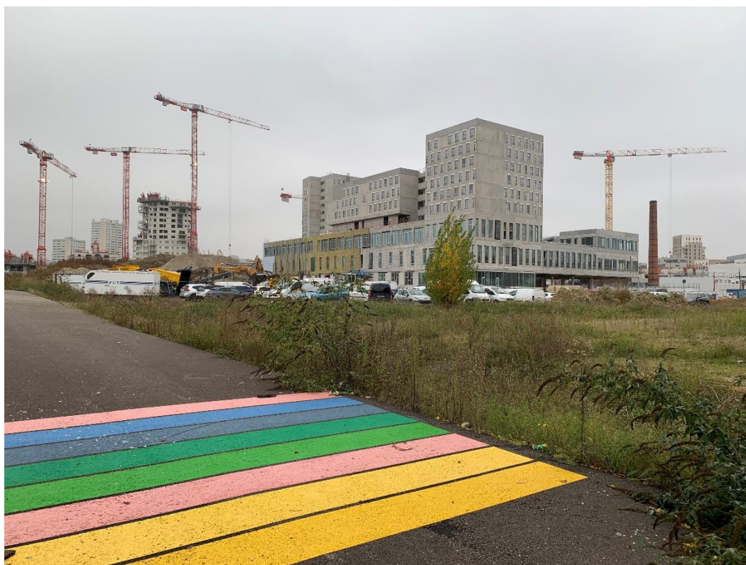
Photographie 14 : Vue de l'emprise 3C depuis le boulevard Paul Vaillant Couturier
