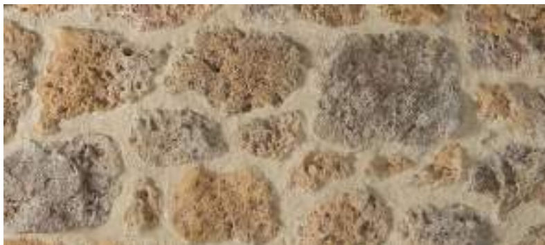
Murets d'entrée de lots en pierre meulière et joints chaux / sable : teintes à respecter
