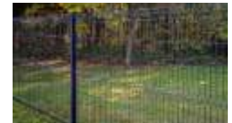
Treillis soudé en limite séparative
