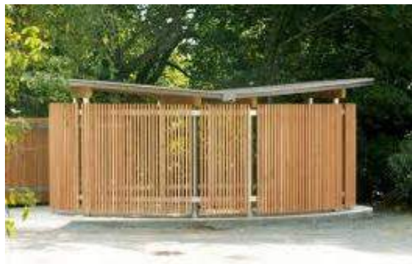
Revêtement en bois
