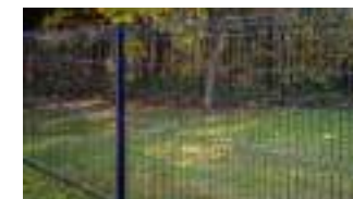
Treillis soudé en limite séparative
