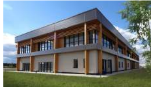
Bâtiment d'activité à Lamirault
