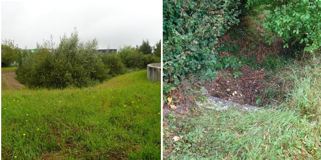
Bassin des eaux pluviales et rejet de la buse dans le fossé le long du CD 153
