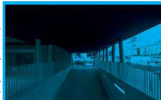
Rampe de parking intégrée au bâtiment avec éclairage naturel
