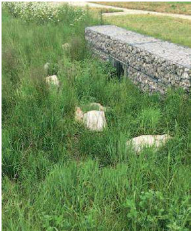
tête de pont de noue pour traverser la voie
