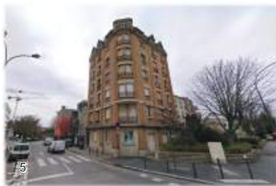
Vue sur un immeuble de logements collectifs situé en bordure de la rue Lafontaine
