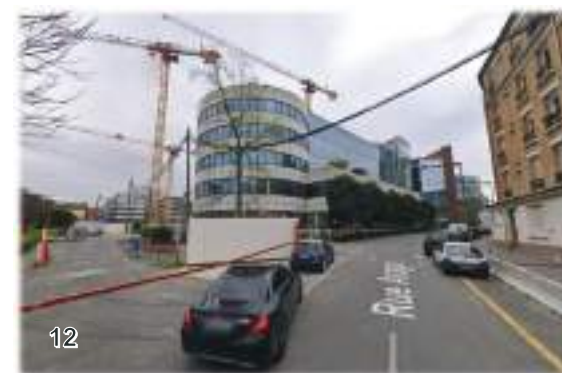
Vue sur l'ancien immeuble de bureaux Colisée I depuis l'intersection de la rue Arago et le Passage Colisée
