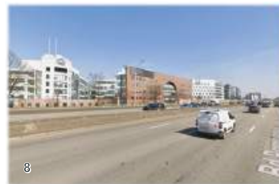
Vue depuis le Boulevard Périphérique intérieur au sud-ouest
