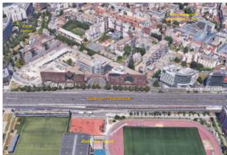
Vue en direction du nord
