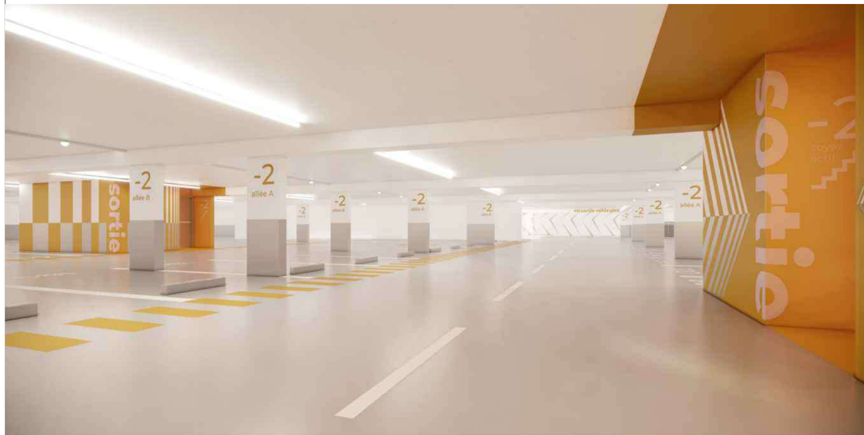
Ambiance et signalétique au niveau -2
