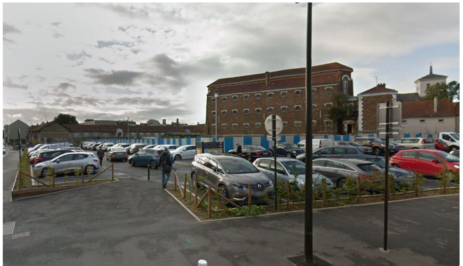
3. VUE DE PUIS CROISEMENT RUE FATOU/ RUE DES COERDELIERS
