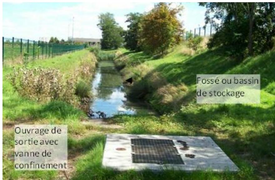
*Figure 13 : Photographie d'un fossé de stockage et du regard sur le puits filtrant le long de l'autoroute A13 (près de la gare de péage)*
