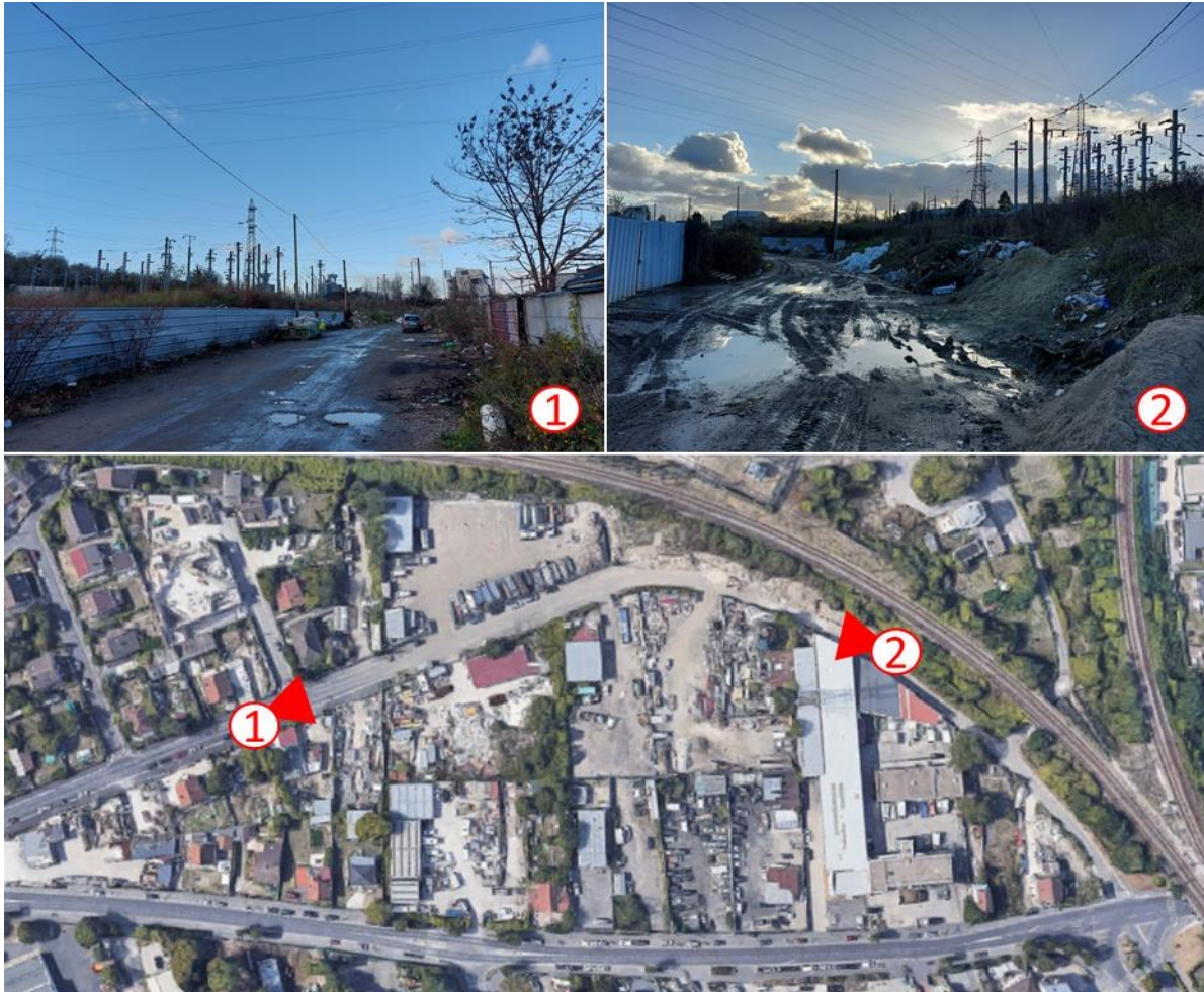
Vue aérienne du site (Source : GoogleMaps) et prises de vue rue de la Liberté (Source : IDFM, décembre 2021)
