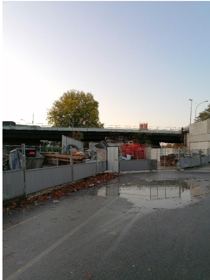
Photographie 19 : Vue du pont (avenue Victor Hugo) depuis le Quai Gambetta
