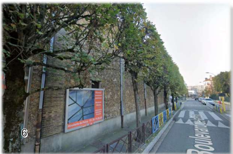
Vue sur les bâtiments en bordure du Boulevard de la Paix
