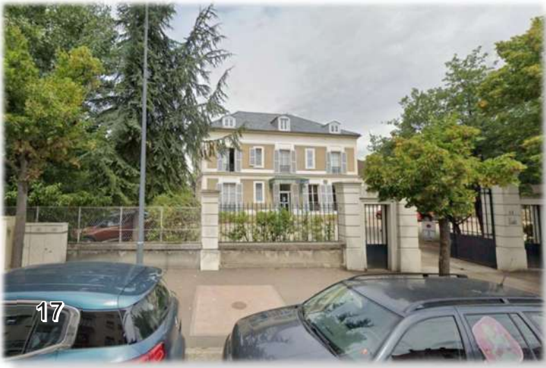
Vue sur des maisons accolées occupées par une office notariale situées en bordure du boulevard Devaux
