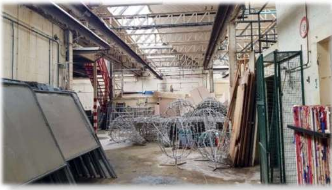
Local de stockage de matériel municipal
