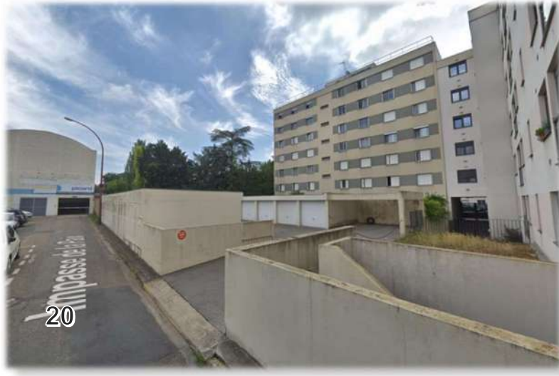
Vue sur la partie arrière ensemble immobilier de logements collectifs situé à l'angle des boulevards de la Paix et V. Hugo
