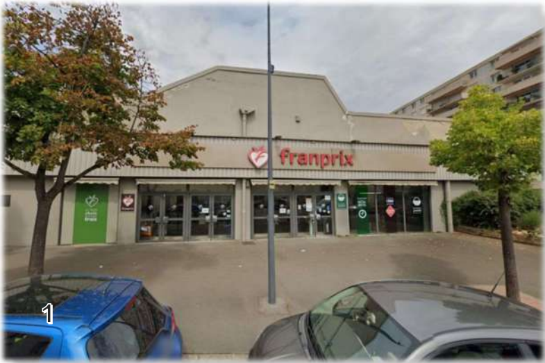
Vue sur l'entrée du magasin de l'enseigne FRANPRIX depuis le boulevard Devaux
