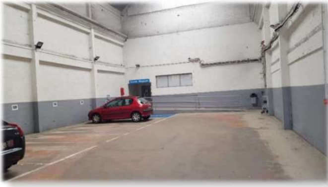
Magasin PICARD (aire de stationnement pour la clientèle en partie arrière, accessible depuis l'impasse de la Paix)
