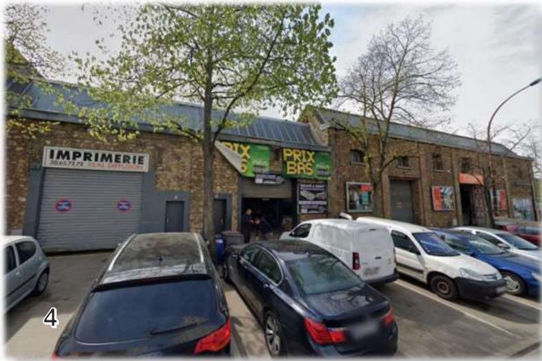
Vue sur les bâtiments depuis la rue P. Codos (avec l'accès à divers locaux commerciaux)
