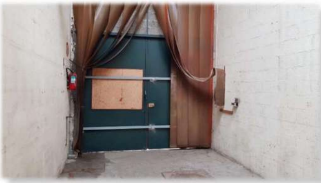
Accès du local inoccupé côté impasse de la Paix
