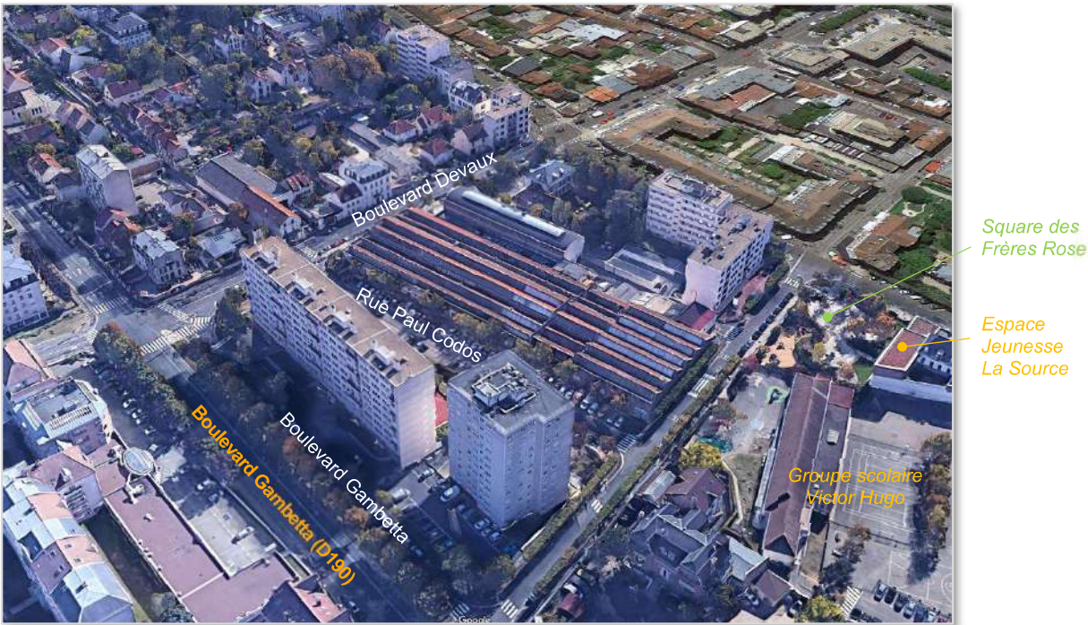
Vue en direction du Sud
