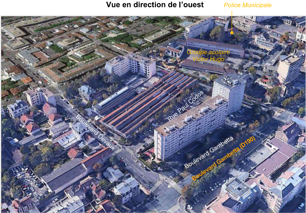
Vue en direction de l'ouest
