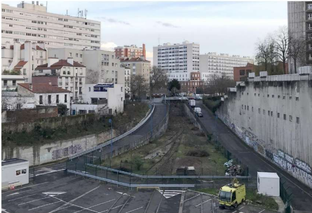
Figure 42 : Vue du périmètre de projet, depuis la dalle haute – état existant
