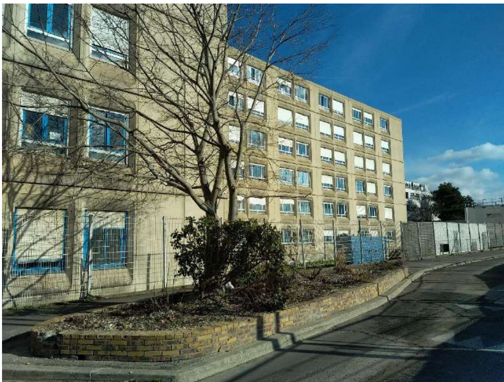
Photographie 9 : Bâtiments de l'hôpital Avicenne AP-HP
