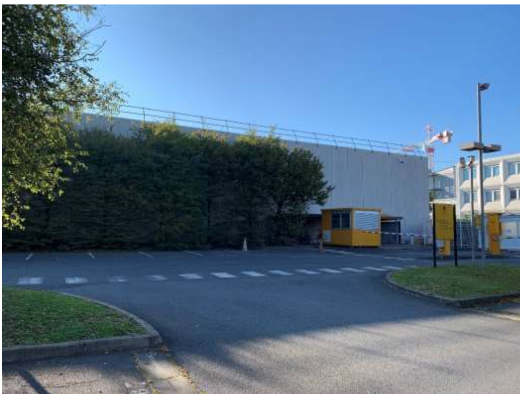
Photographie 20 : Vue de l'entrepôt situé au Sud-Ouest de la parcelle
