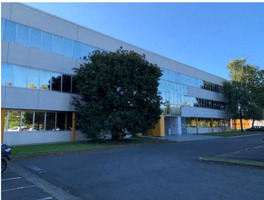
Photographie 18 : Vue du bâtiment de bureau bordant la rue Valiton
