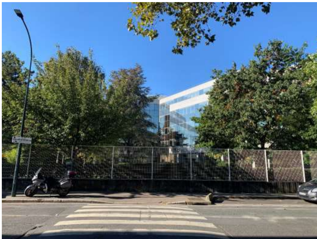
Photographie 11 : Vue vers le bâtiment principal depuis la rue Ferdinand Buisson
