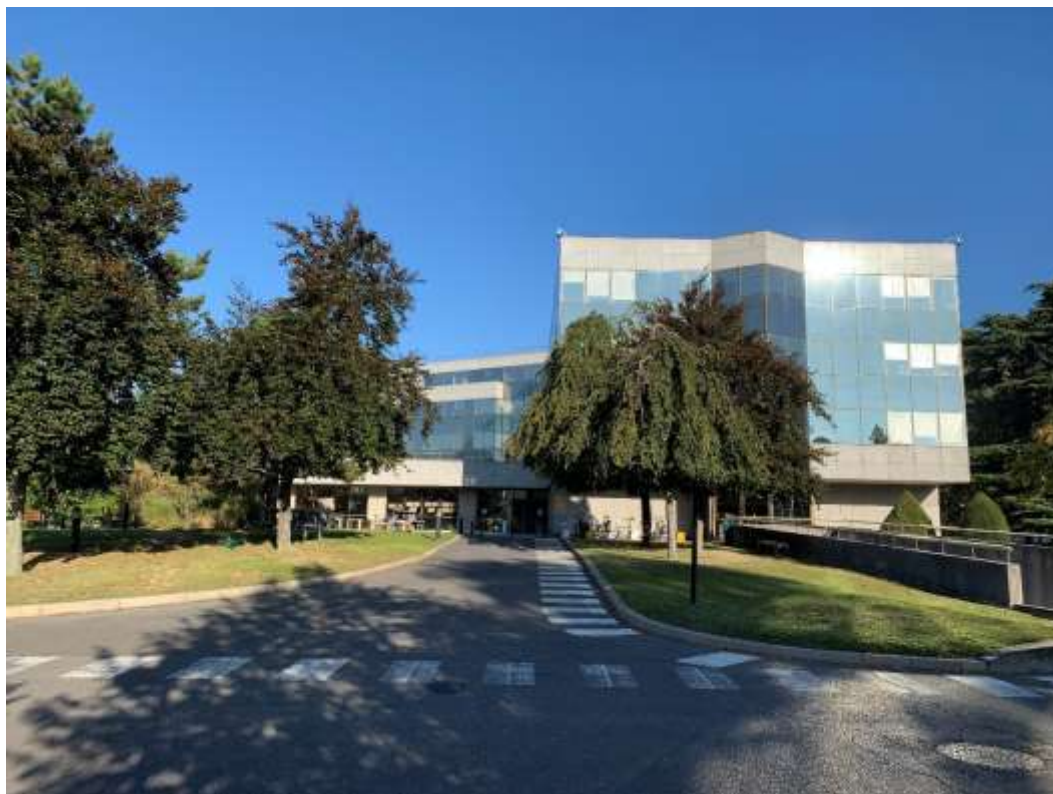
Photographie 13 : Vue de l'aile Sud du bâtiment principal
