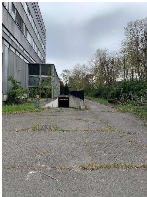
Photographie 4 : Vue de l'entrée du niveau de sous-sol
