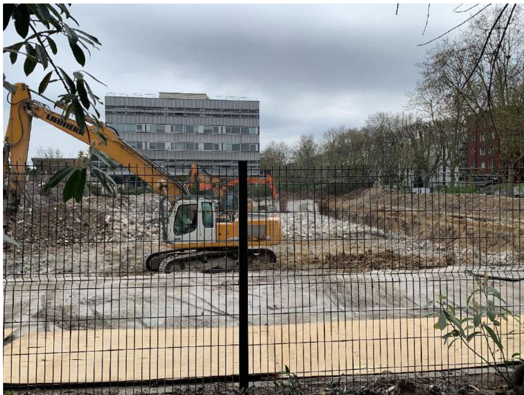
Photographie 15 : Vue du chantier depuis le Nord
