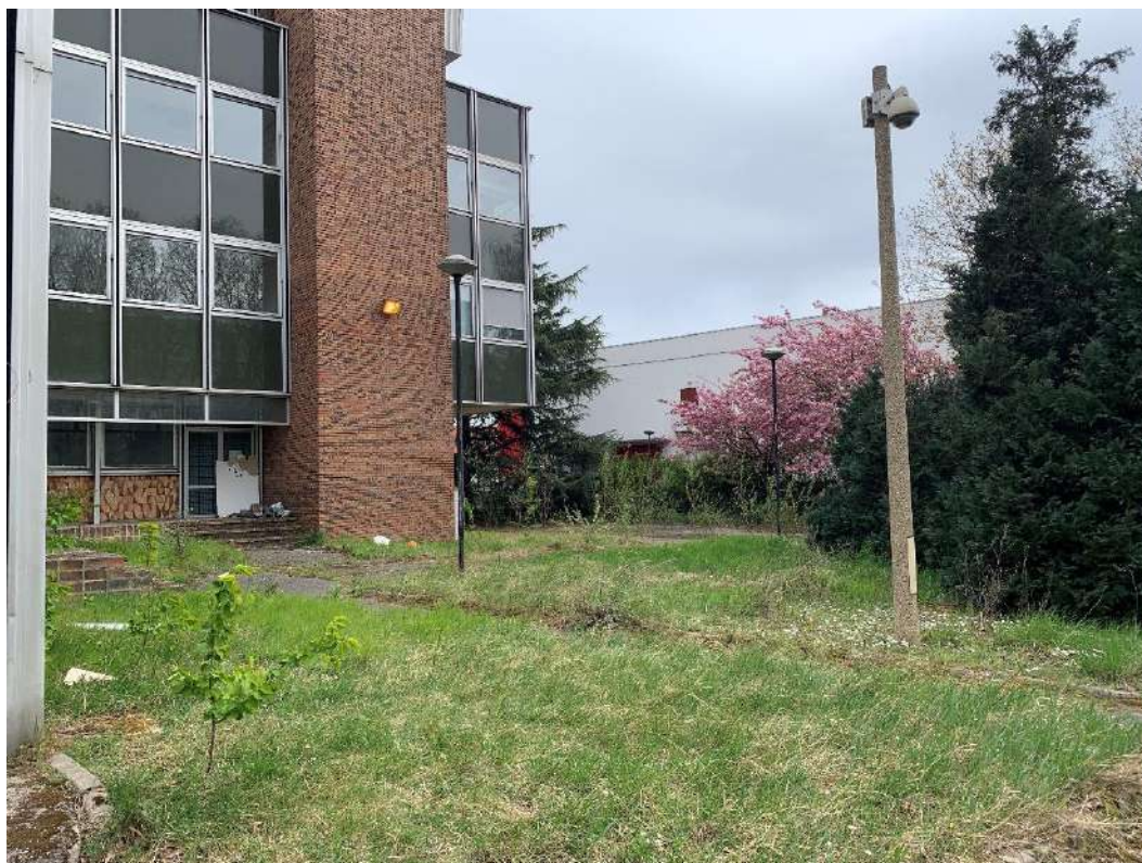
Photographie 6 : Vue de l'angle Sud-Ouest du bâtiment
