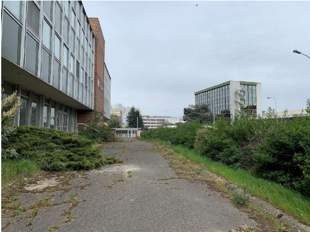
Photographie 9 : Vue vers le Nord de la bordure Est de la parcelle
