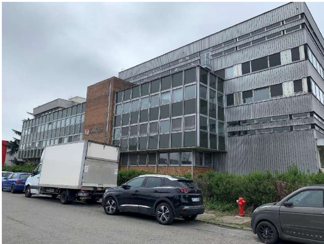
Photographie 1 : Vue du bâtiment depuis la rue Charles Martigny
