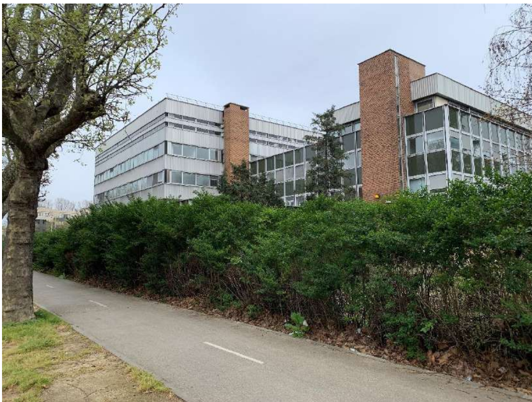
Photographie 14 : Vue du bâtiment depuis la rue Jean Jaurès
