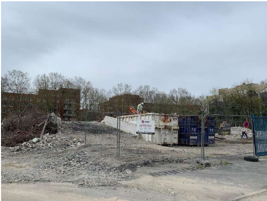
Photographie 13 : Vue du chantier sur la parcelle voisine située au Nord
