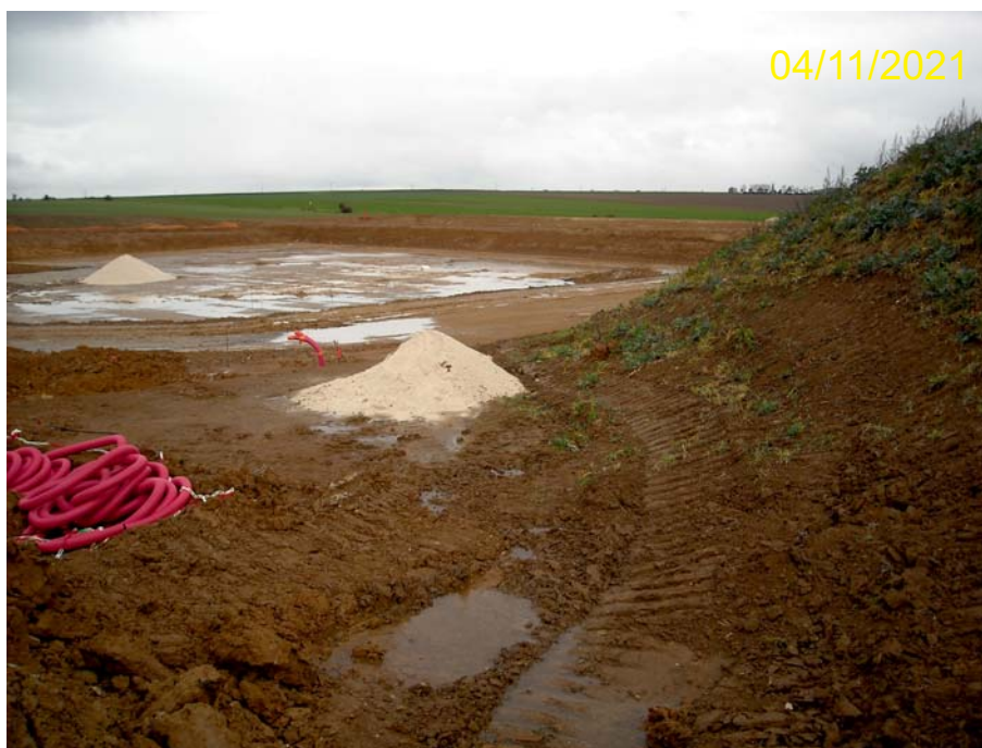
1. Vue rapprochée du site d'implantation
