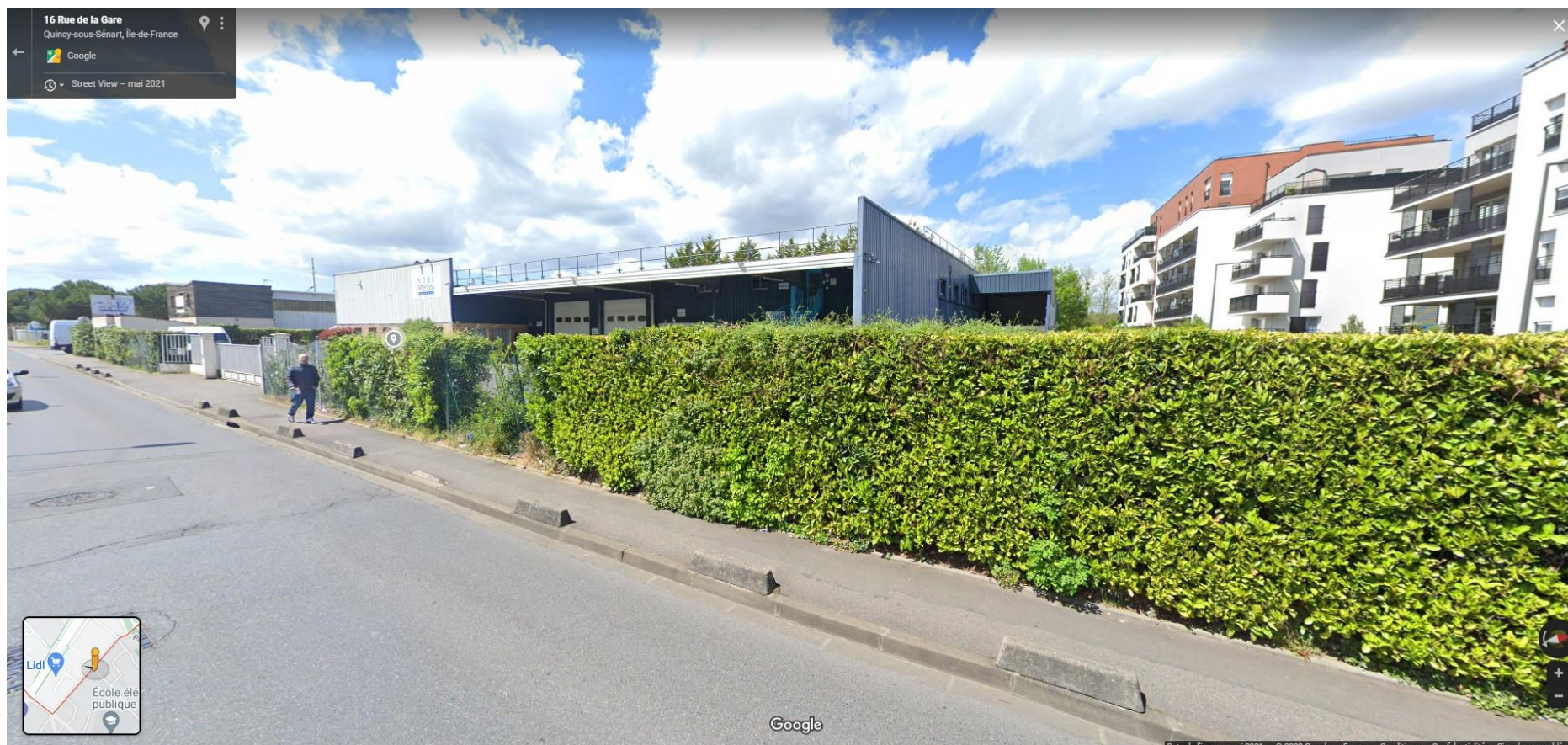
Vue 1 du site d'accueil du projet par la rue de la Gare (Source : Street View)
