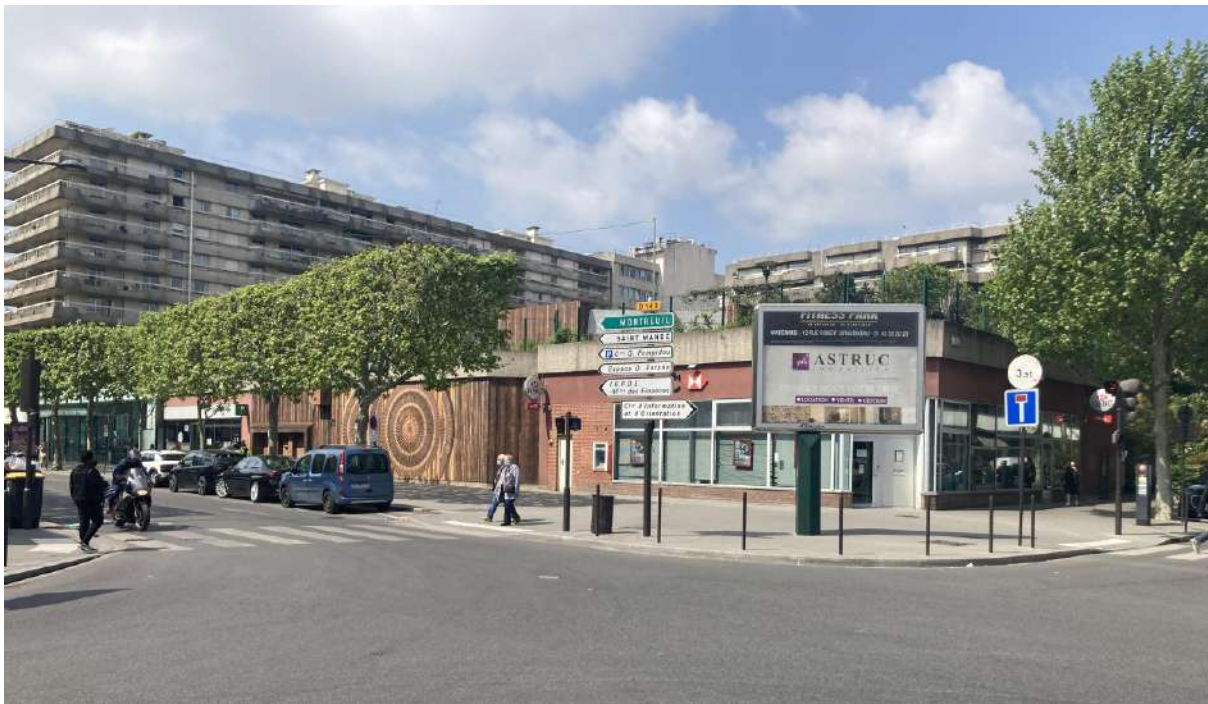
Photo de côté du bâtiment existant, depuis l'angle rue de Fontenay/avenue du château (2)
