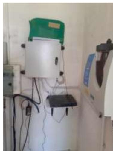
Figure 13 : Analyseur de chlore, coffret électrique et Soffrel
