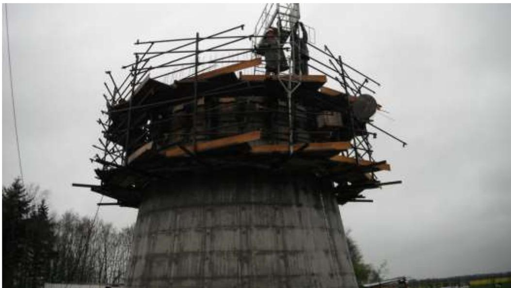
*Figure 16 : Utilisation de coffrages grimpants pour réaliser le réservoir sur tour de la Paquetterie*
