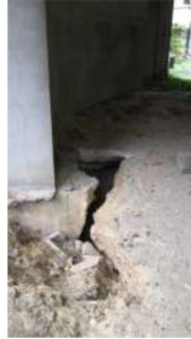
Figure 5 : Réservoir R1 : affaissement dallage + Fissures circconférentielles et radiales en dalle de couverture (rapport STRUCTUREO)
