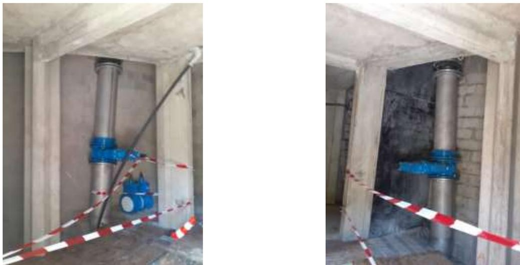
Figure 8 : Tuyauteries et vannes DN400 non raccordées
