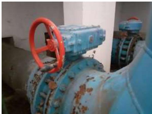
Figure 12 : Tuyauteries sous cuve (à gauche : TP/vidange et refoulement/distribution ; à droite : refoulement/Distribution et refoulement et au centre : vanne d'isolement refoulement fermée et distribution ouverte)
