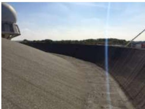
*Figure 17 : Etanchéité bitumineuse sur la toiture d'un réservoir sur tour de 2850 m<sup>3</sup>*
