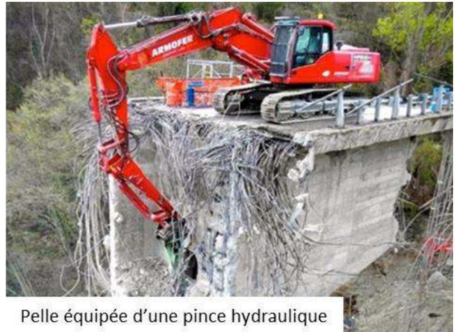
Pelle équipée d'une pince hydraulique
