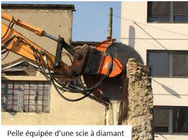
Pelle équipée d'une scie à diamant
