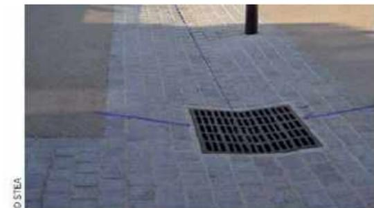
Tranchée drainante sèche avec caniveau en béton poreux – ZAC Boucicaut, Paris 15<sup>e</sup>
