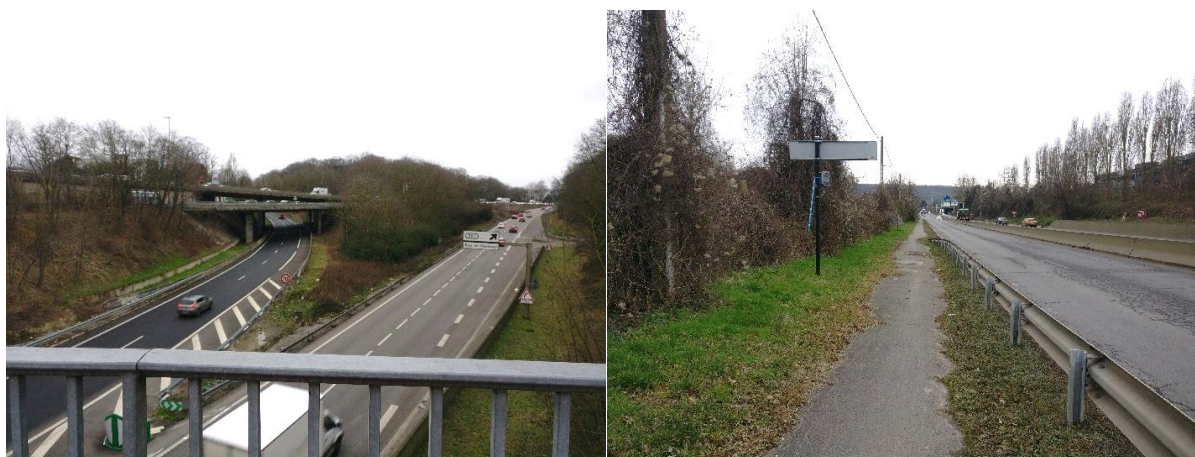
Figure 40. Vue de l'A86 depuis une passerelle piétonne (à gauche) et piste cyclable dangereuse le long de la N 306 (à droite) (Artelia, 02/2022)
