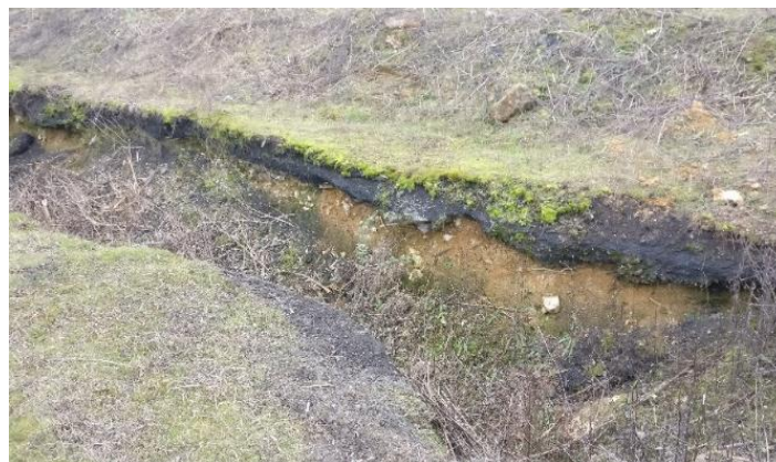
Figure 15. Aperçu du sol avec la couche de mâchefers sur le site (Artelia, 02/2022)
