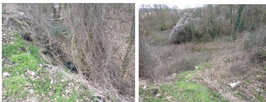
Figure 19. Aperçu de la brusque rupture de pente au sud de l'emprise projet (Artelia, 02/2022)
