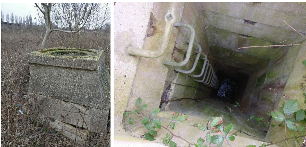
Figure 26. Aperçu de la Sygne canalisée depuis un regard (Artelia, 02/2022)
