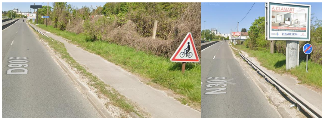
Figure 38. Piste cyclable existante avant la parcelle du projet et fin de piste au niveau de la parcelle (Google Maps)
