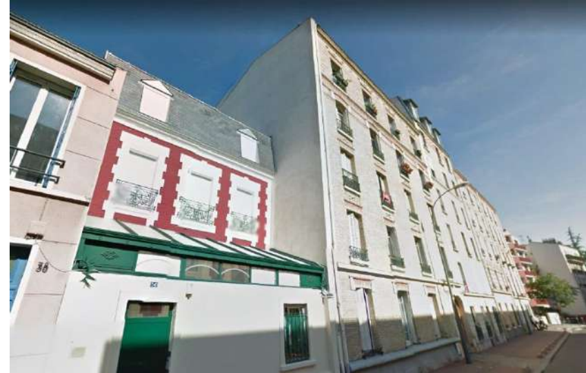
Figure 8 : Vue à l'Ouest de la parcelle (source : Google Maps)
