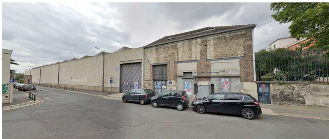
Figure 4 : Photo du terrain au Nord-Est (source : Google Street View)
