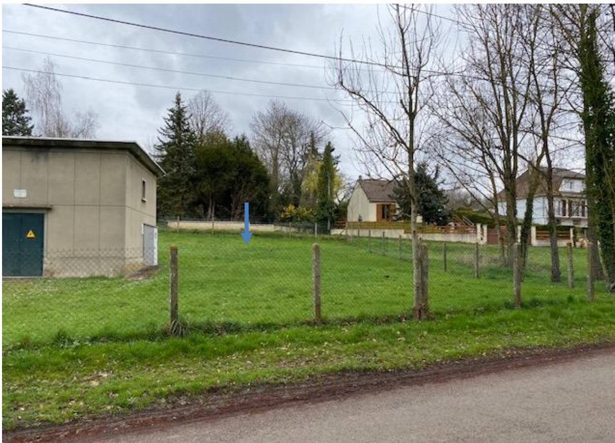
Figure 5 : Implantation du projet de forage F2 sur la parcelle B 933 (vue en direction du Nord)
