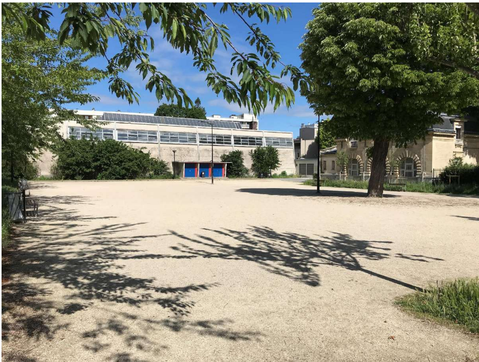
Photographie 9 : Vue sur le Gymnase Guy Moquet et le Boulodrome Roger Billaux
