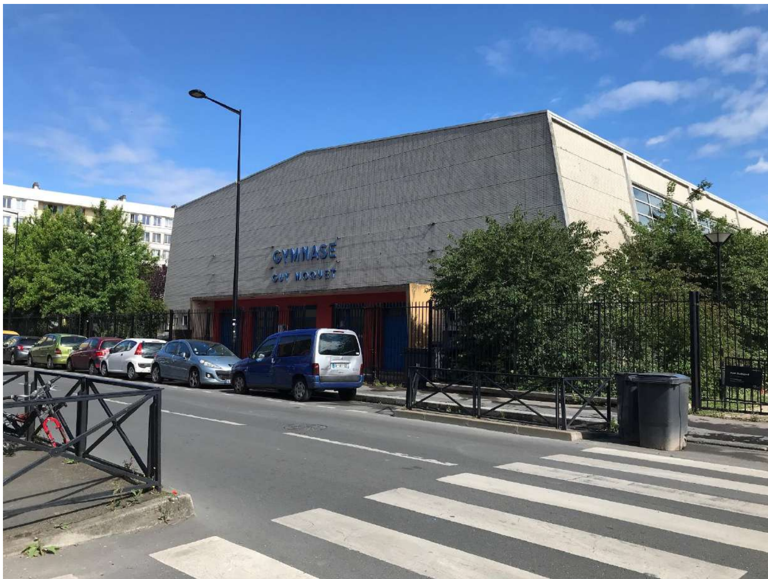
Photographie 10 : Vue de la façade principale du Gymnase Guy Moquet donnant sur la Rue Edouard Poisson
