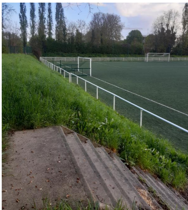
Photographie 8 : Escalier d'accès du local ouest depuis les terrains de sport
