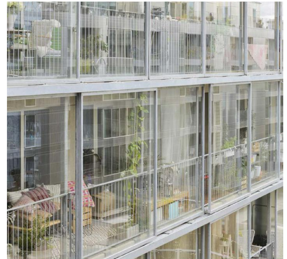
DES JARDINS D'HIVER CRÉENT UNE DOUBLE PAROI ET RENFORCENT LA PROTECTION AU BRUIT DES LOGEMENTS Stockholm Suède (arch: ArrhovFrick Architecte)
