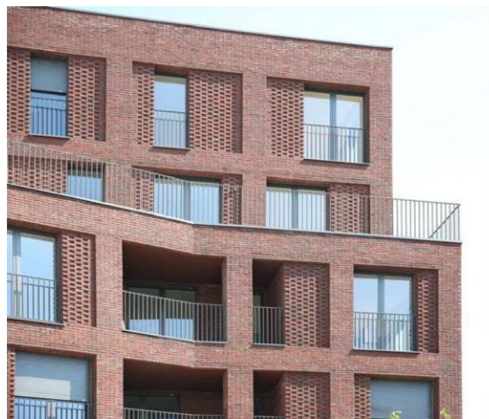
MODÉNATURE EN BRIQUE Pantin (93) (arch: Avenier Cornejo)
