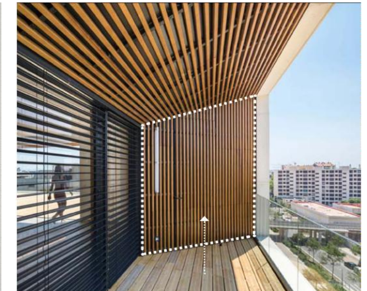
ESPACE DE RANGEMENT EXTÉRIEUR DANS LA CONTINUITÉ D'UNE LOGGIA, Lyon Confluence (arch: G. Le Penhuel + Z architecture)
