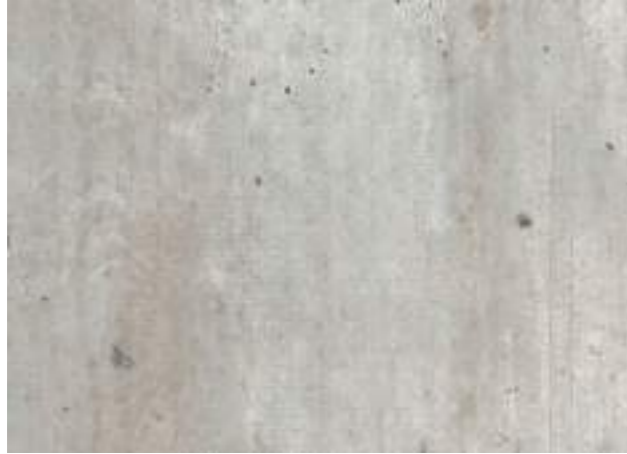
Murs de refends Béton naturel lisse
