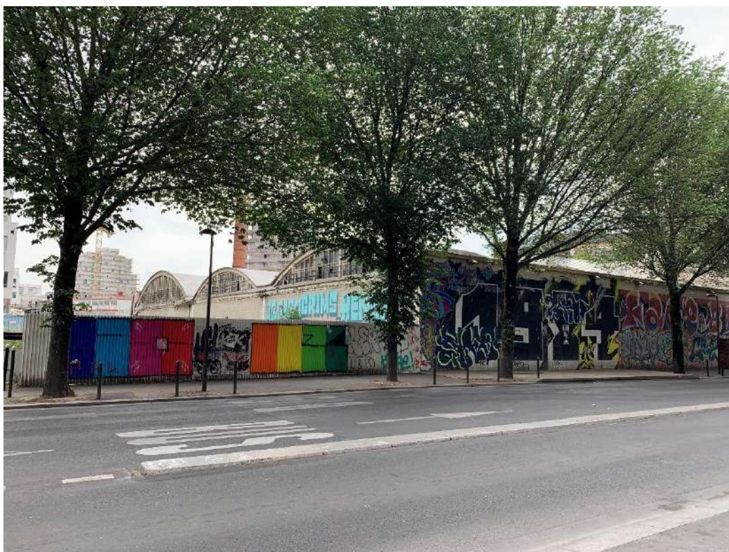
Photographie 8 : Vue des hangars et du lot 3D de puis le boulevard PV Couturier
