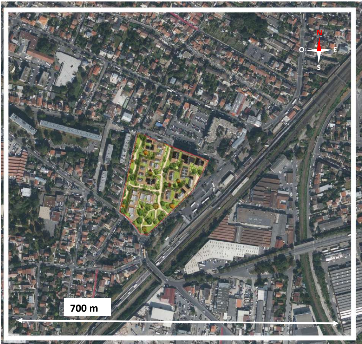
Figure 3 : Vue aérienne du domaine d'étude
