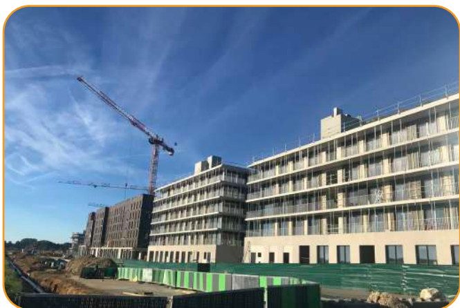
(3) - Vue vers l'est sur les autres lots en construction de la ZAC de Sycomores (source TRANS-FAIRE, 2022)
