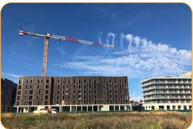
(7) - Vue sur les autres lots en construction de la ZAC des Sycomores à l'ouest du lot SY26B1 (source TRANS-FAIRE, 2022)
