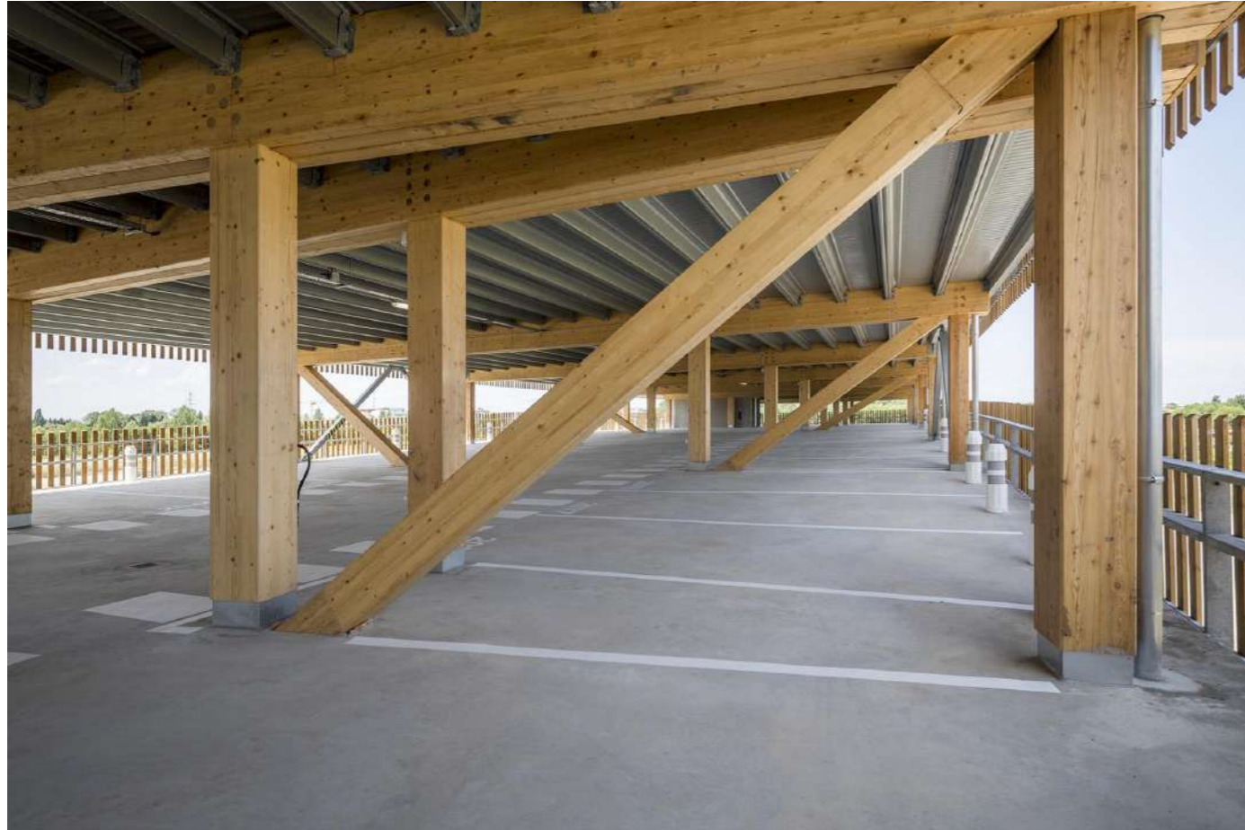
Parking silo - ZAC des Rives du Bohrie - JAP
