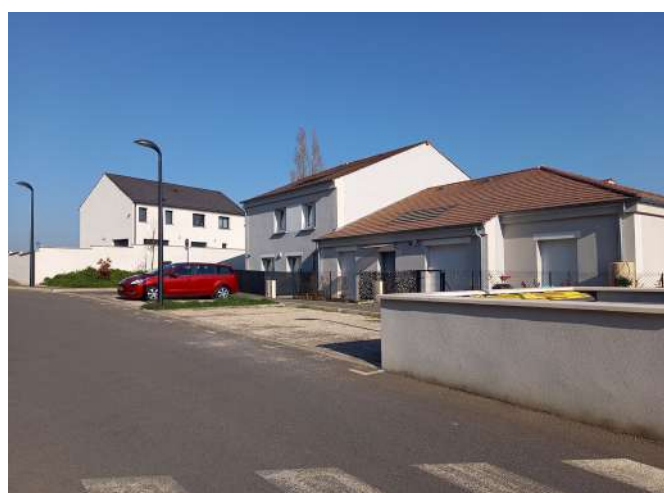
1- Bâtiment résidentiel (source TRANS-FAIRE, 2022)
