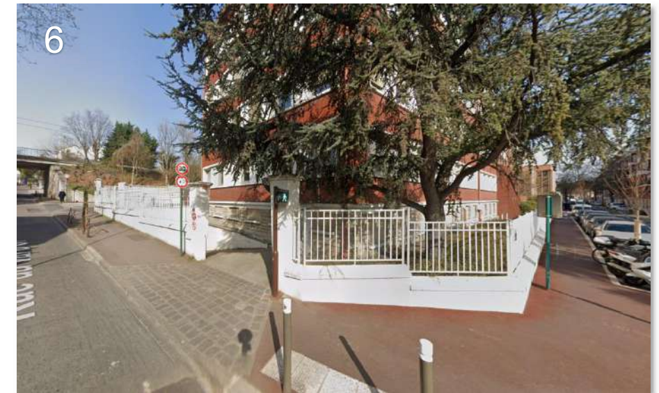
Vue depuis l'intersection formée par les rues de la République et du Val d'Or sur l'accès des véhicules au sous-sol
