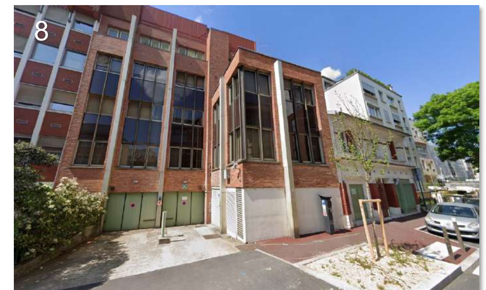
Vue depuis la rue de la République sur l'accès / sortie des véhicules au parking du site
