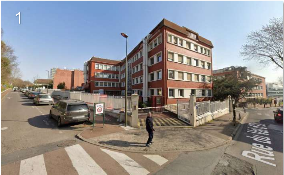
Vue depuis l'intersection formée par les rues des Moulineaux et du Val d'Or sur l'accès livraison des marchandises
