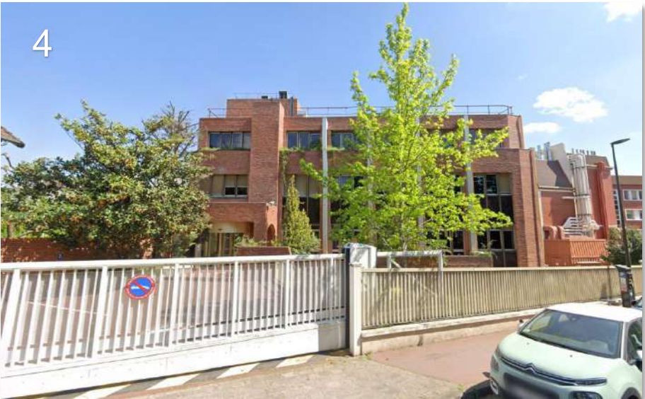
Vue depuis la rue des Moulineaux au niveau de l'accès principal au site
