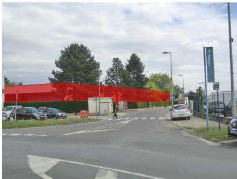
01 - Vue du bâtiment à démolir depuis la rue Pierre et Marie Curie
