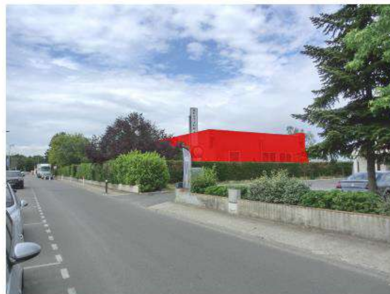
02 - Vue du bâtiment à démolir depuis le rond-point
