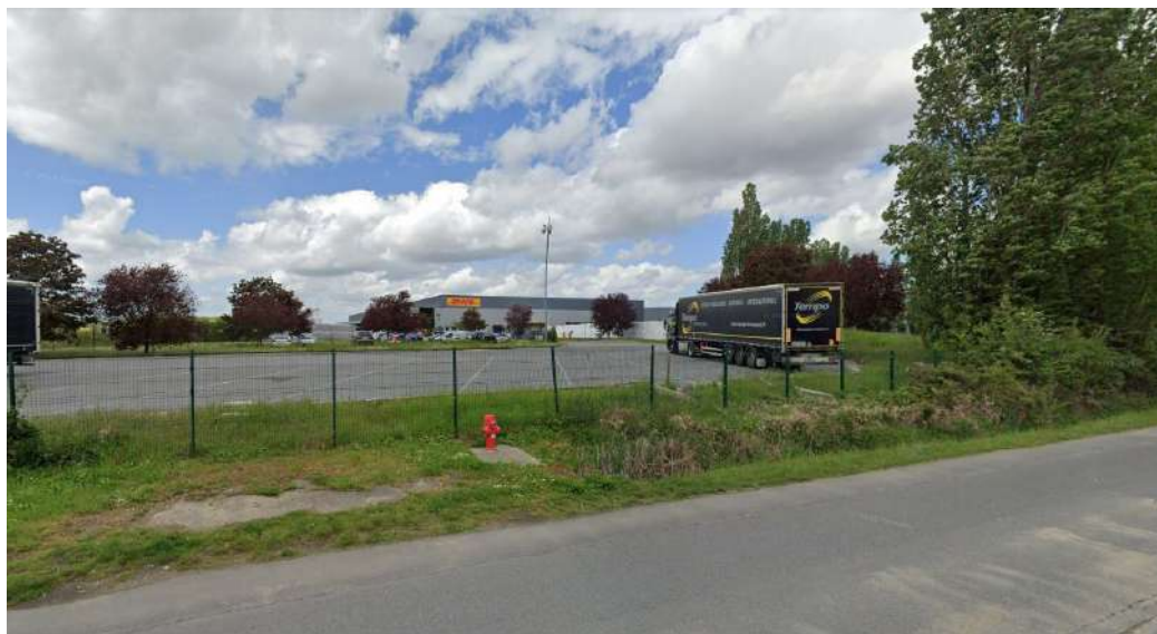
1. VUE DEPUIS LA ROUTE DES LOGES VIA LA D19 - VUE SUR LA SEQUENCE D'ENTREE DES POIDS LOURDS
