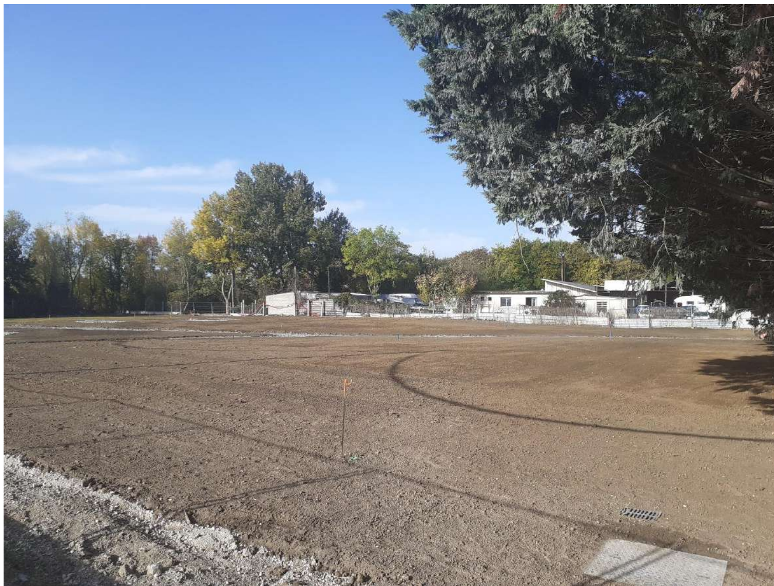
Photographie 15 : Vue depuis le chantier d'Urbanera sur le site en direction du nord-ouest
