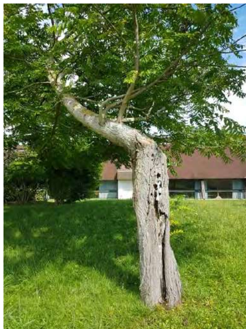
Pterocaryon du Caucase n°89 : tronc écimé, totalement dégradé – unique charpentière insérée derrière la dégradation
