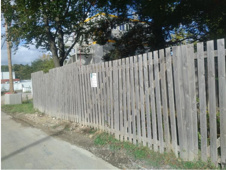
Figure 87. Exemple de protection d'arbres au sein d'un chantier
