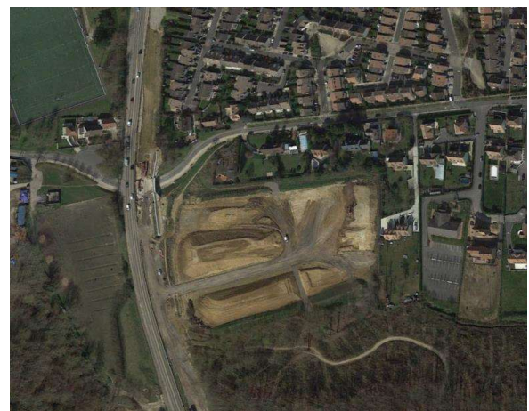
Zone d'étude en 2016 (décapage et stockage de terres)
